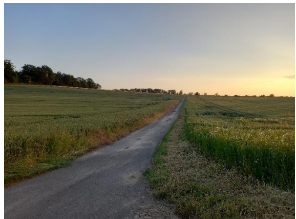
Abbildung 7: Asphaltierter Feldweg im Zentrum des Geltungsbereiches
