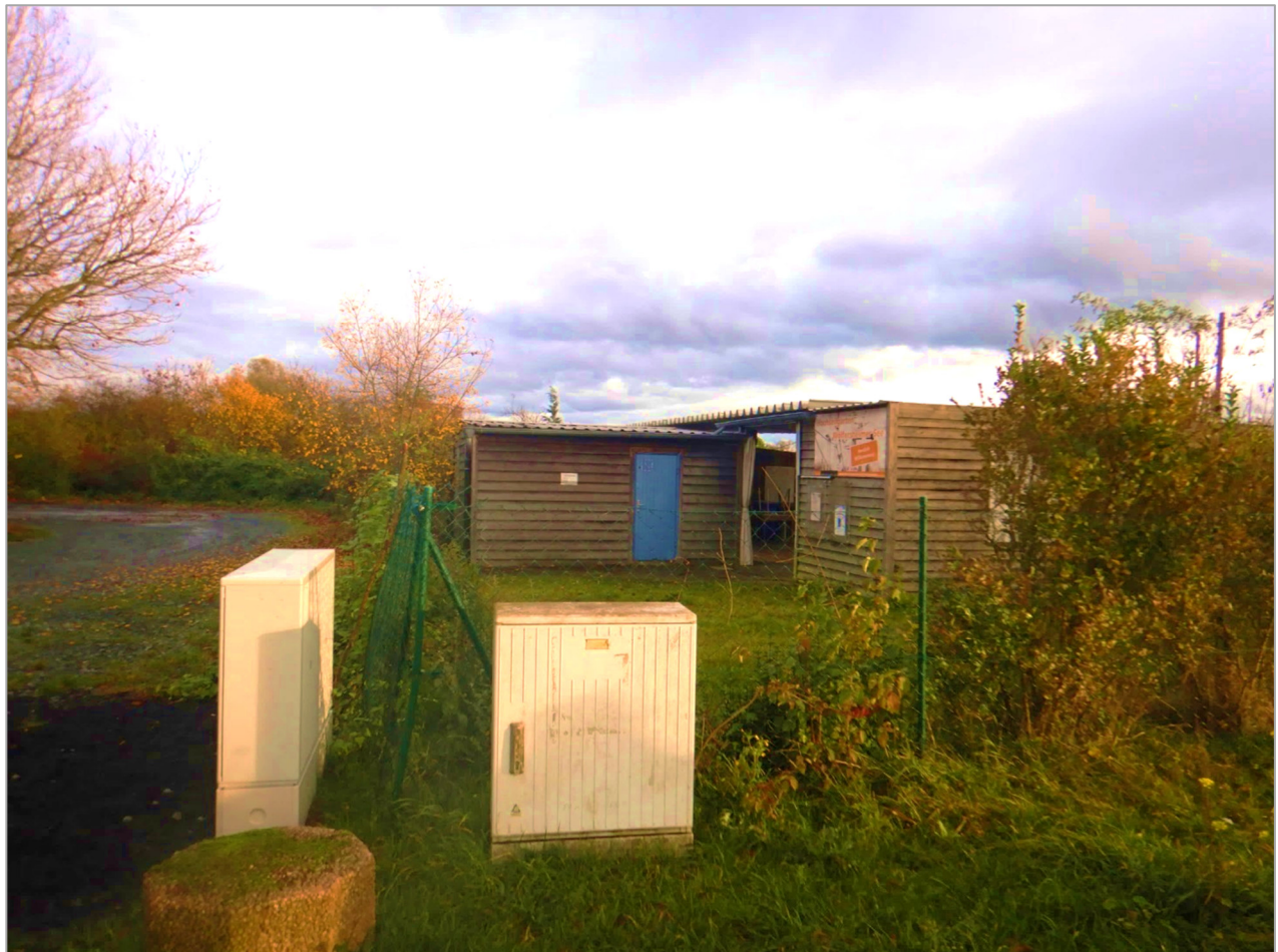
Abb. 10 Bestandsgebäude „Hochseilgarten Wölfersheimer See“ (Begehung 20.11.2023).
