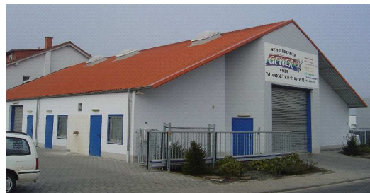
Werkstatt und Lager der Firma Geller im Industrie- und Gewerbegebiet Berstadt, Ottostr. 3
